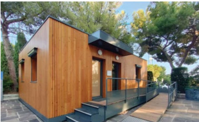
CRÉATION DE BUREAUX TEMPORAIRES SUR LE PARVIS DU MINISTÈRE D'ÉTAT
