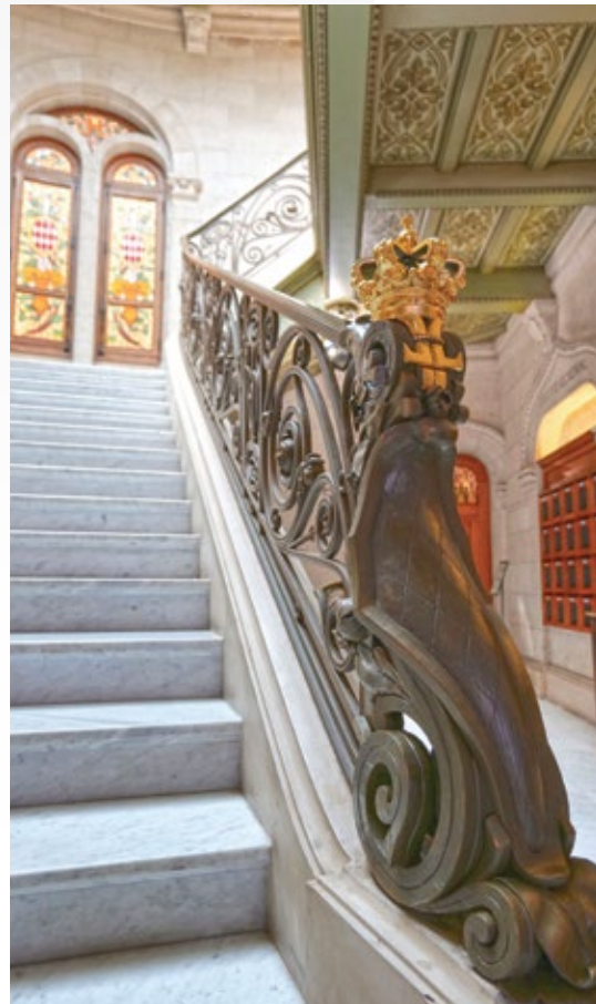
RÉNOVATION DES GARDE-CORPS DU PALAIS DE JUSTICE
